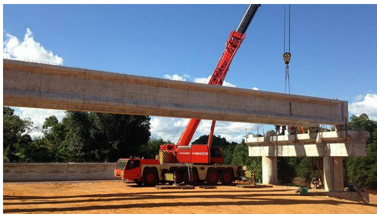
Figura 17: Içamento e alocação de viga pré-moldada
