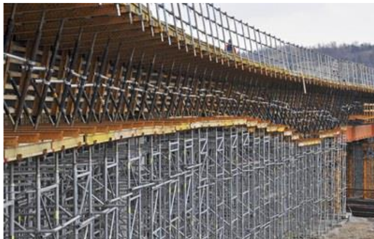
Figura 12: Ponte construída sobre cimbramento fixo
