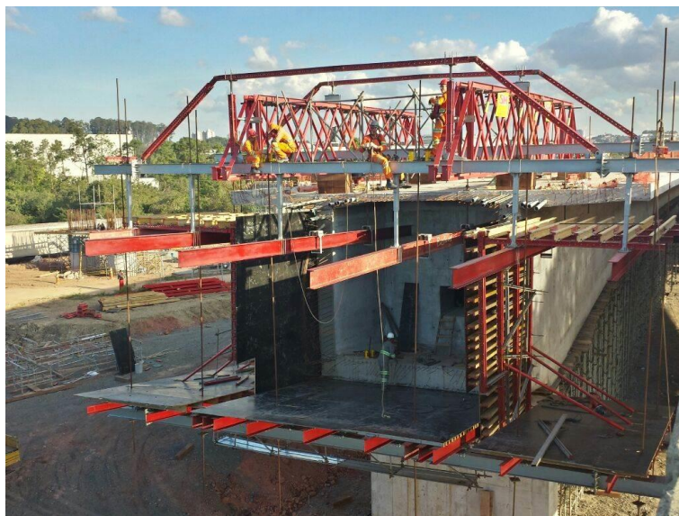
Figura 16: Método dos balanços sucessivos com aduelas moldadas no local
