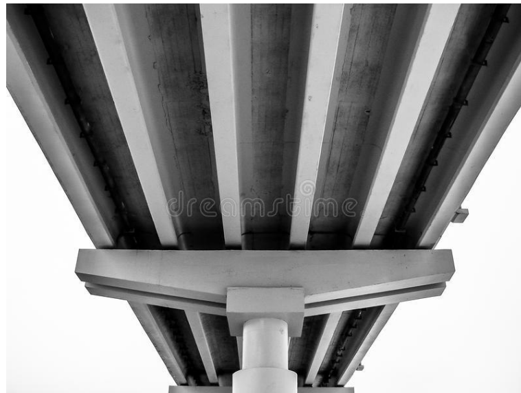
Figura 6: Ponte em vigas de alma cheia
