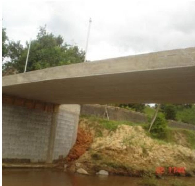
Figura 5: Ponte em laje
