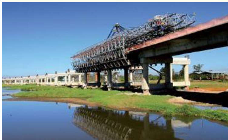
Figura 13: Ponte construída com cimbramentos móveis
