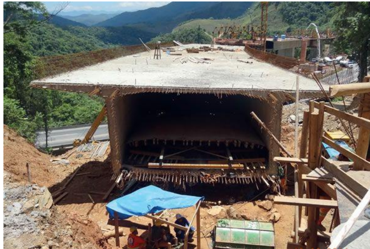
Figura 7: Ponte em seção celular
