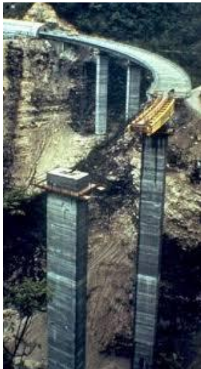
Figura 18: Ponte construída pelo método dos deslocamentos progressivos
